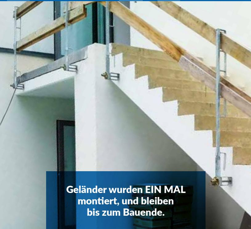
**Geländer wurden EIN MAL montiert, und bleiben bis zum Bauende.**
